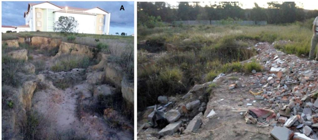
**Figura 4** - A – tentativa de contenção do ravinamento com blocos de cimento; B - preenchimento das ravinas por restos de construções. Fonte: Autores.
